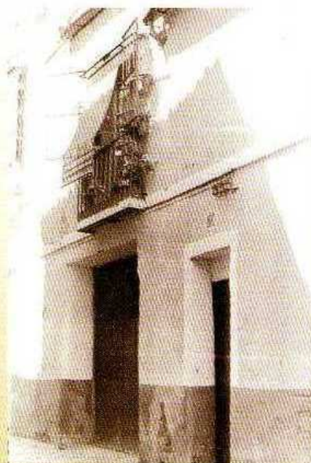
Fachada Casa Hermandad antes de cesión.
